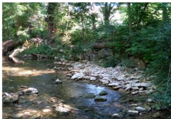
Figure 30 : Secteur 4 - Enrochement rive gauche en état moyen (désordre 3)
