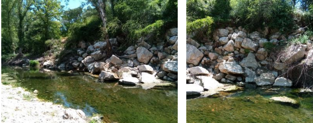
Figure 9 : Secteur 1 - Protection de berge en mauvais état en rive droite.
