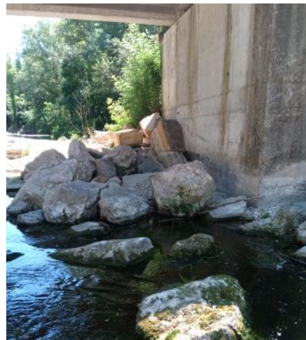
Figure 8 : Secteur 1 - Anse d'érosion en amont de la protection de berge rive droite (en haut à gauche), protection de berge en mauvais état (en haut à droite), érosion à l'amont de la culée du pont (en bas à gauche), blocs désorganisés en pied de culée (en bas à droite).
