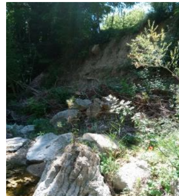
Figure 4 : Secteur 1 - Protection de berge en rive droite. A gauche, on visualise le début de contournement par l'amont et à droite le secteur érodé à l'aval avec des blocs désorganisés en pied.
