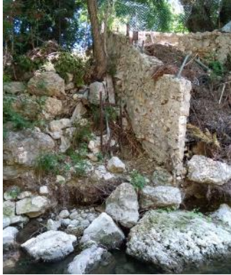
Figure 16 : Secteur 2 - Protections de berges en mauvais état en rive gauche.
