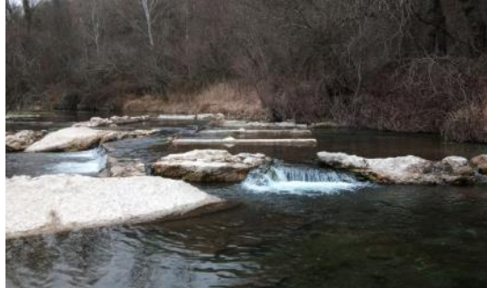
Figure 111 : Radier béton à supprimer.
