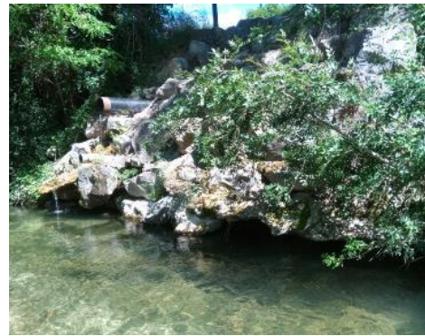
Figure 22 : Secteur 3 - Vue des enrochements bétonnés en mauvais état à l'amont du pont rouge.
