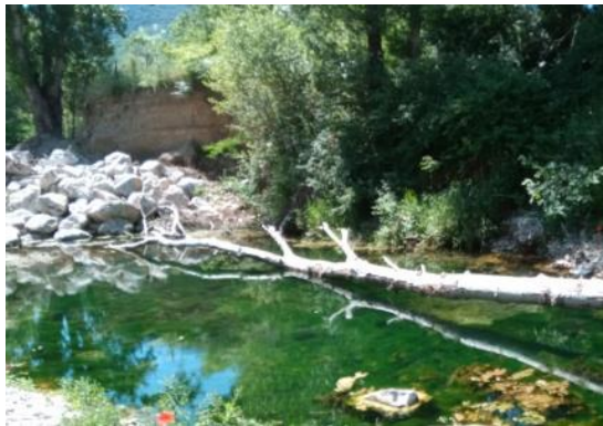
Figure 4 : Secteur 1 - Protection de berge en rive droite. A gauche, on visualise le début de contournement par l'amont et à droite le secteur érodé à l'aval avec des blocs désorganisés en pied.
