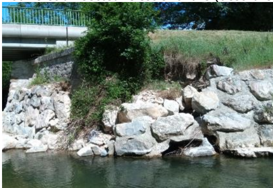
Figure 22 : Secteur 3 - Vue des enrochements bétonnés en mauvais état à l'amont du pont rouge.
