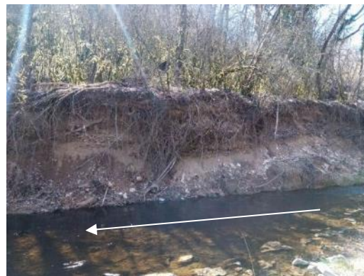
Figure 34 : Secteur 4 -berge érodées à l'aval du secteur en rive gauche (à g.) et rive droite (à dr.) (désordre 7)
