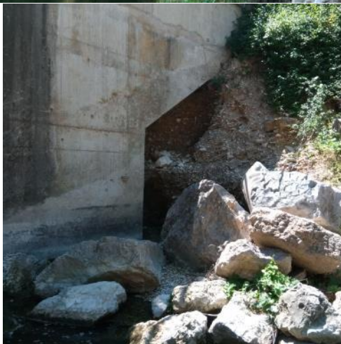
Figure 8 : Secteur 1 - Anse d'érosion en amont de la protection de berge rive droite (en haut à gauche), protection de berge en mauvais état (en haut à droite), érosion à l'amont de la culée du pont (en bas à gauche), blocs désorganisés en pied de culée (en bas à droite).
