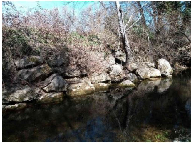
Figure 33 : Secteur 4 - Enrochement rive gauche en état moyen (désordre 6)
