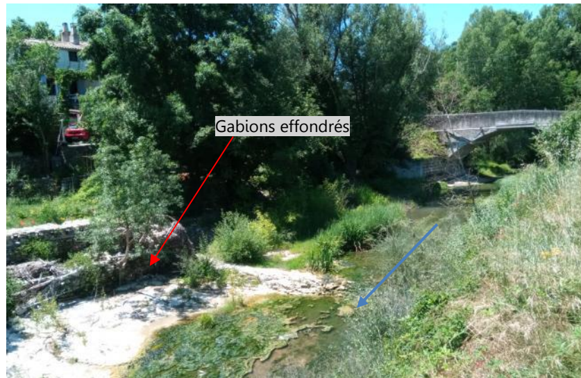
Figure 13 : Secteur 2 - Protections de berge effondrées en rive droite.
