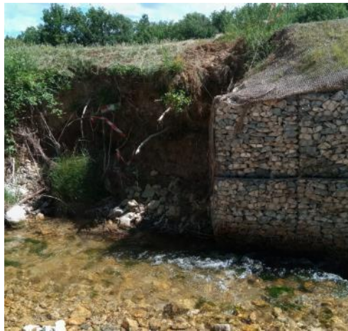
Figure 21 : Secteur 3 - Anse d'érosion qui s'est développée à l'aval des gabions.
