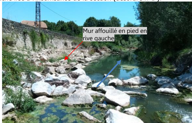
Figure 14 : Secteur 2 - Erosion de la berge rive gauche à l'aval du seuil.
