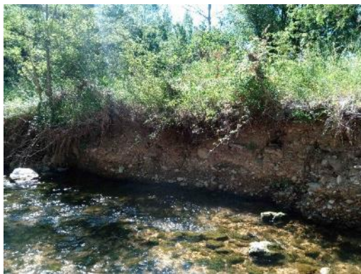
Figure 29 : Secteur 4 - Erosion de berge correspondant au désordre n°2
