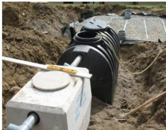
*Assainissement non collectif composé d'un bac dégraisseur, d'une fosse toutes eaux et d'un filtre à sable drainé*
